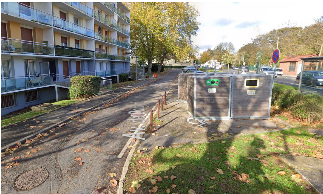
N°101 avenue de Domont – Bornes aériennes (mises en place en 2020)
