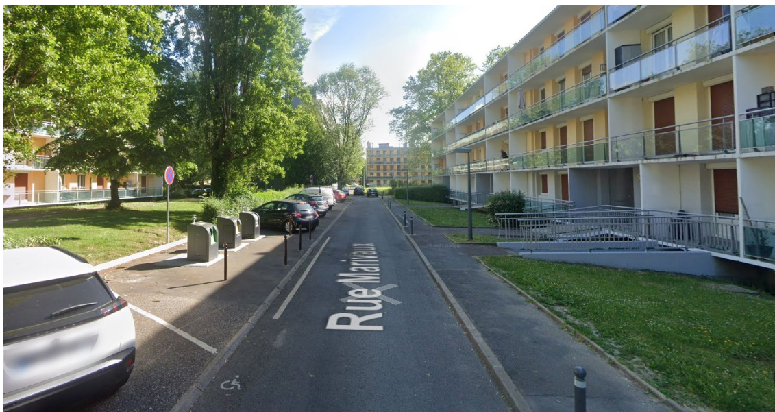
Face n°7 rue Marivaux – Bornes enterrées (mises en place en 2020)
