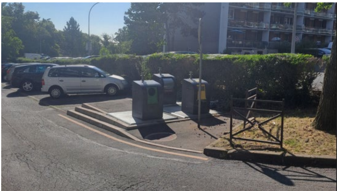
Face au n°11 rue Pascal – Bornes enterrées (mises en place en 2018)
