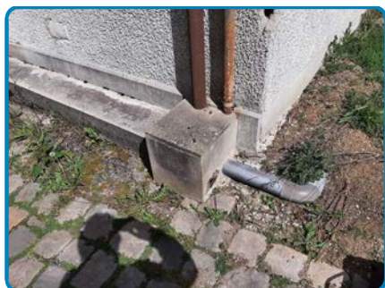
Descente EP arrière
