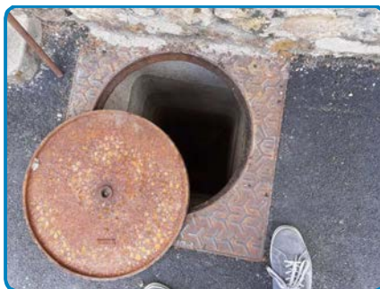
Regard Eaux usées 2
