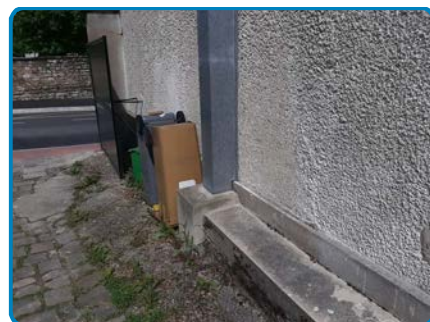
Descente Eaux usées sur Eaux pluviales
