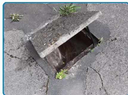
Regard supposé d'eaux usées se déversant sur regard du domaine public
