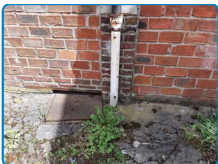
Eaux pluviales sur puisard
