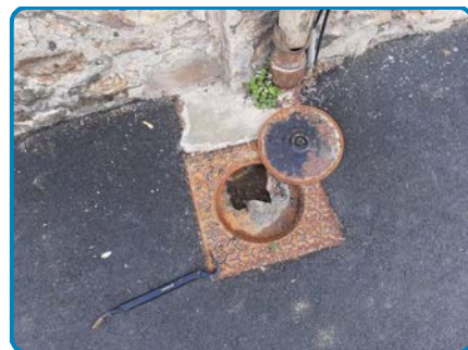
Regard Eaux pluviales (descente avant) vers caniveau de rue
