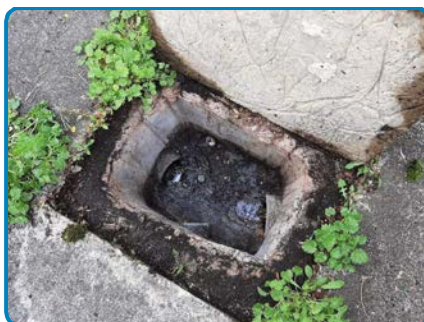
Absence de constatation d'écoulement
