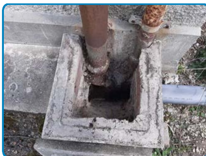
Regard Eaux pluviales arrières
