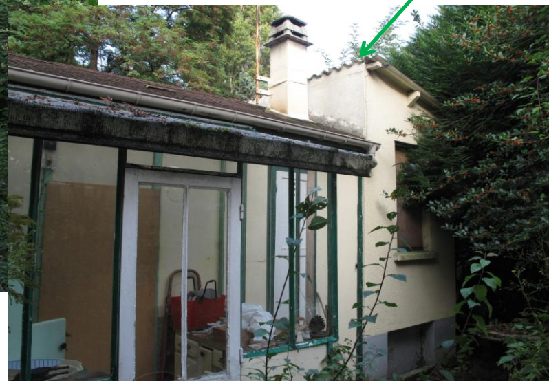
Toiture fibro ciment
